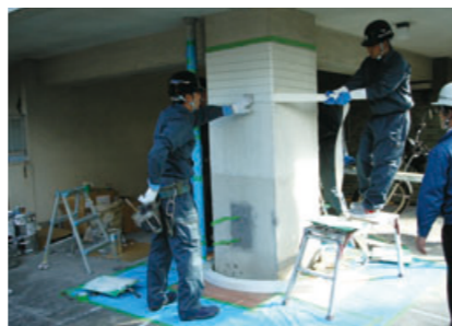
SRF工法での耐震改修。既存の柱に、ポリエステル繊維のベルトを包帯のように巻きつける
