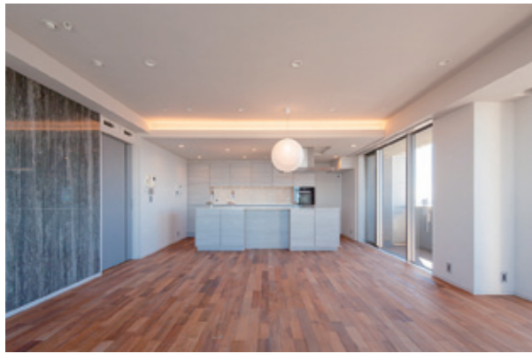
既存住宅のリノベーション工事事例
